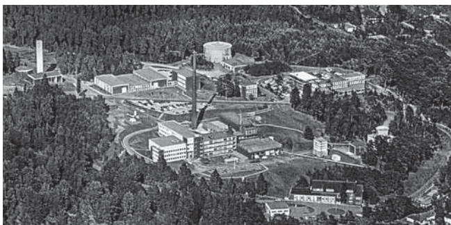
Luftbild der Gesellschaft für Kernenergieverwertung in Schiffbau und Schifffahrt in Geesthacht Anfang der 1970er Jahre. Foto: Luftamt Hamburg (Freigabe Nr. 2293/71)
