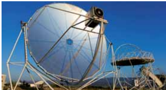
Dish-Stirling-Anlage: Parabolspiegel bündeln die Sonnenstrahlung in einem Brennpunkt. Die Wärmeenergie wird durch einen Stirling-Motor in mechanische Energie umgewandelt, die ein Generator zur Erzeugung von Elektrizität nutzt. Foto: DLR/Ernsting
