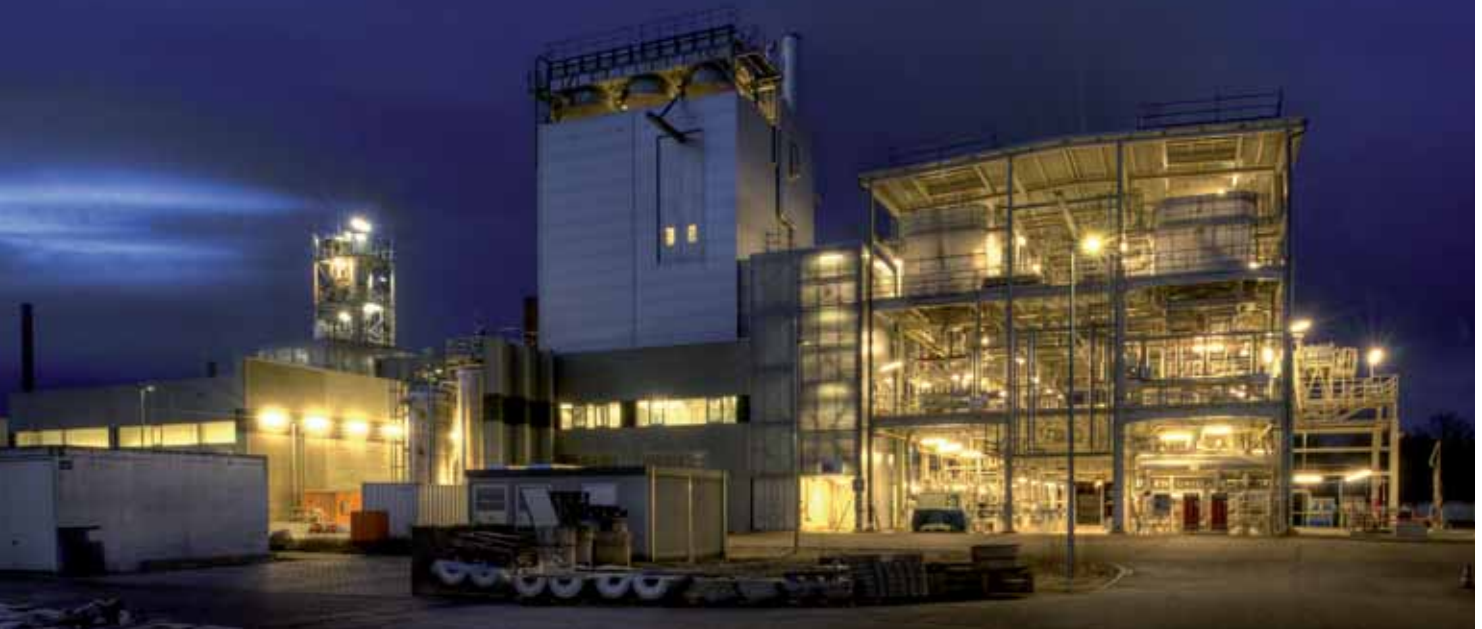
In der bioliq®-Pilotanlage wird Restbiomasse wie Stroh oder Holzabfälle in umweltfreundliche und motorenverträgliche synthetische Kraftstoffe umgewandelt. Foto: KIT
