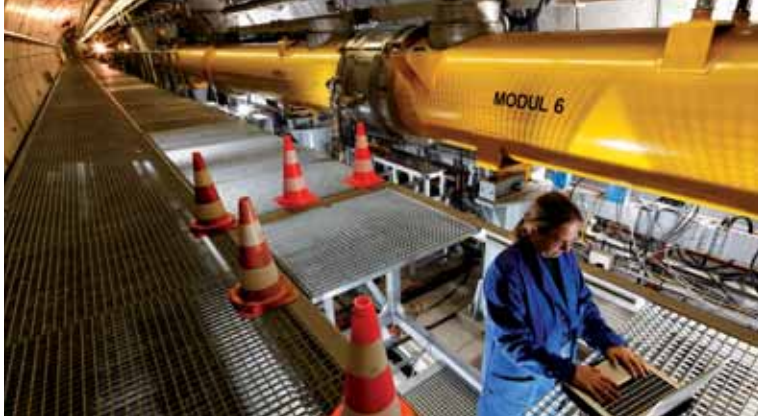
Beschleunigertunnel des Freie-Elektronen-Lasers FLASH. In den großen gelben Modulen werden Elektronen fast bis auf Lichtgeschwindigkeit beschleunigt. Foto: DESY
