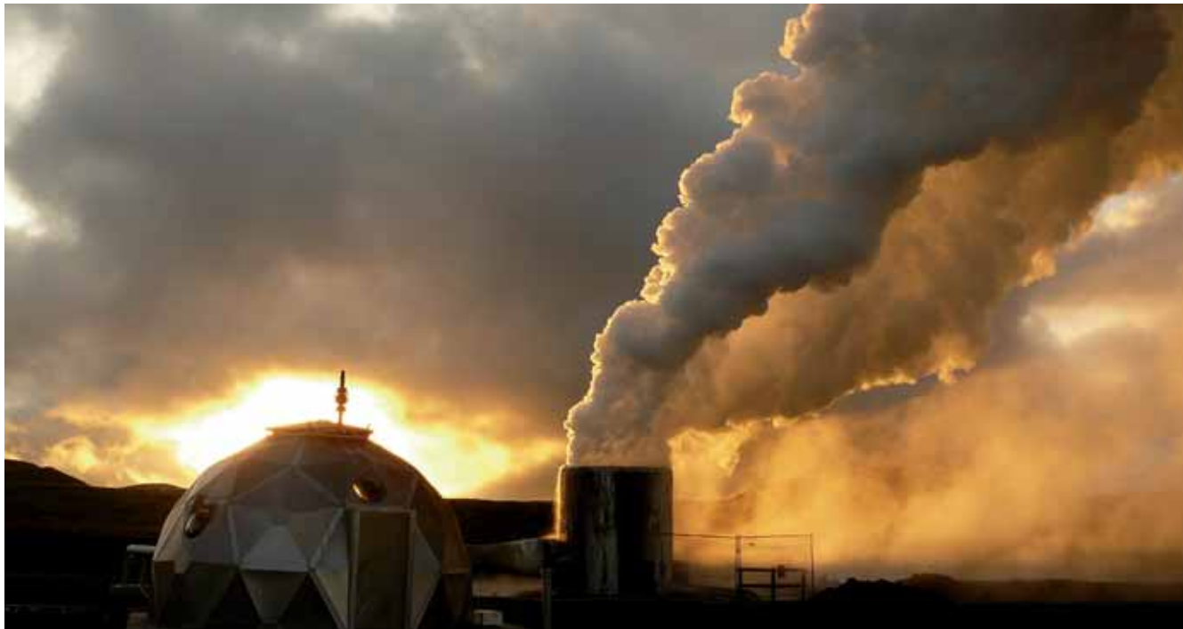
Island ist eine der geothermisch aktivsten Regionen der Welt: Geothermie-Bohrung HE-53 im Geothermalfeld Hellisheiði in Südwest-Island während eines Produktionstests. Foto: GFZ/T. Reinsch
