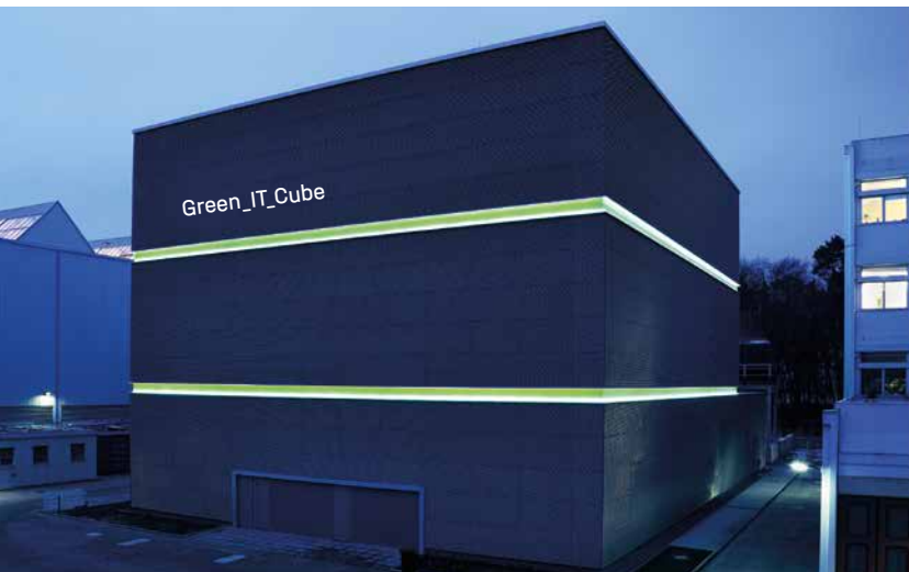
Photo: G. Otto GSI Helmholtzzentrum für Schwerionenforschung GmbH
