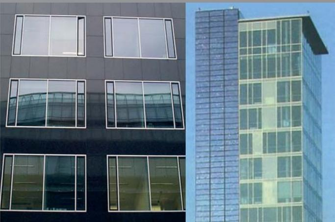
SO ELEGANT WÜRD EINE FASSADE MIT SCHWARZEN CIS-MODULEN (IM MODELL, LINKS) AUSSEHEN; DANEBEN EINE FASSADE MIT KONVENTIONELLEN SOLARZELLEN. Foto: Nikolaus Meyer
