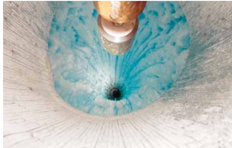
DIE BOHRUNGEN FÜR ICECUBE WERDEN MIT HEISSEM WASSER IN DAS ANTARKTISCHE EIS GESCHMOLZEN. Foto: J. Bolmont
