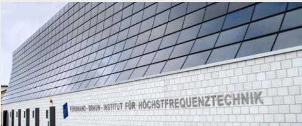
Die Fassade des Ferdinand-Braun-Instituts wurde mit CIS-Solarmodulen aus Kupfer, Indium und Schwefel der Firma Sulfurcell ausgestattet. Bild: FBH/P. Immerz
