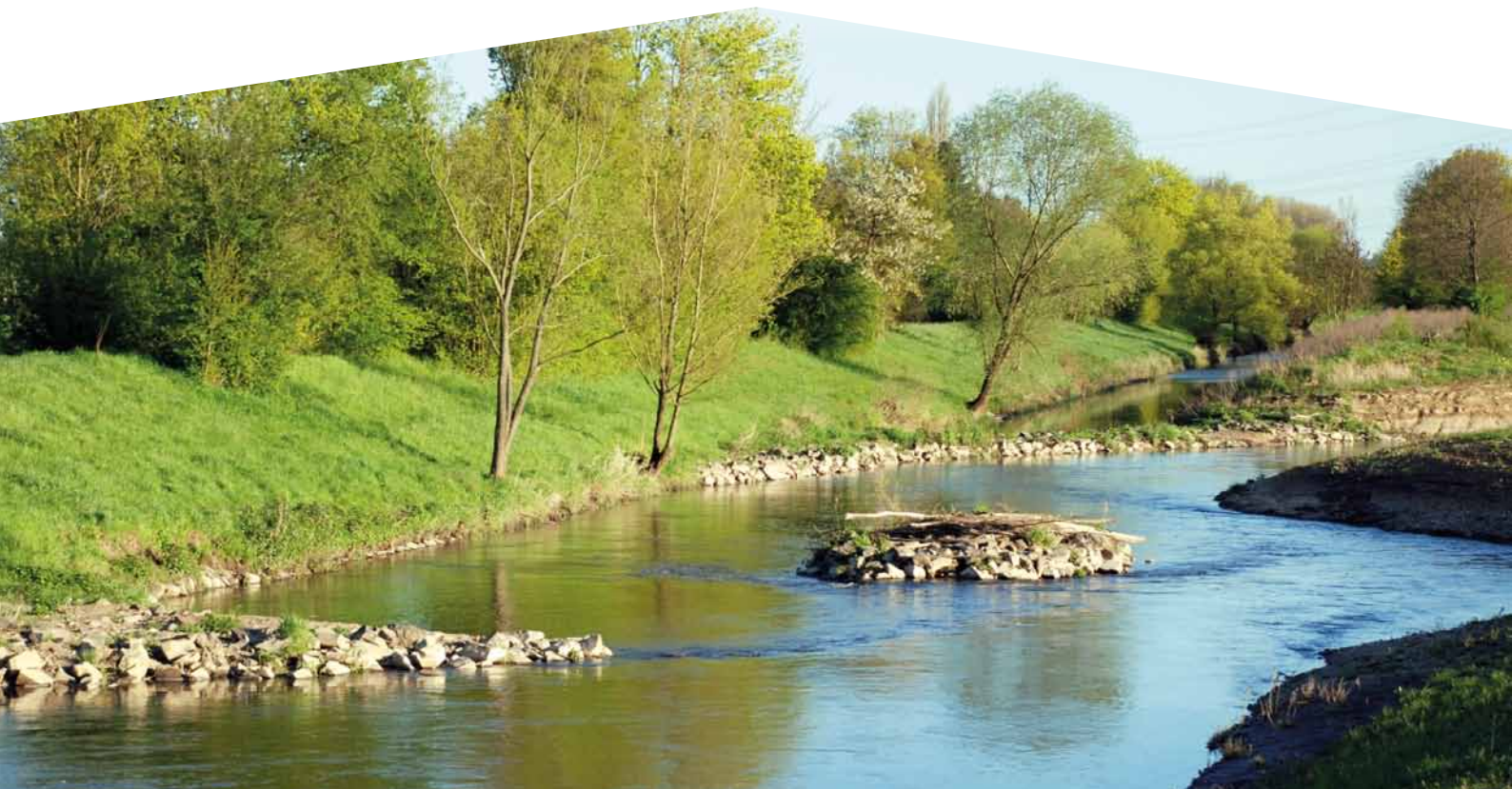
Investition in die Zukunft: Dass die Nidda nahe der hessischen Stadt Karben renaturiert wird, führt auch zu einem besseren Hochwasserschutz. Extensiv genutzte Weiden am Ufer „darf“ der Fluss überfluten. Bild: hahilnchen/Fotolia
