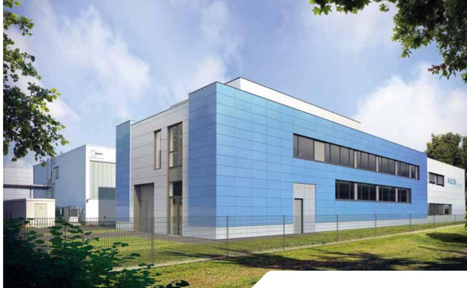
Teilchenbeschleuniger *BERLinPro* gebaut. Und an den Fassaden kommen Photovoltaikmodule zum Einsatz. Die Halle wird damit in zweierlei Hinsicht zum Reallabor: Im Innern werden Geräte getestet, bevor sie im Teilchenbeschleuniger zum Einsatz kommen. Und außen entsteht Sonnenstrom, der im HZB genutzt werden kann.
