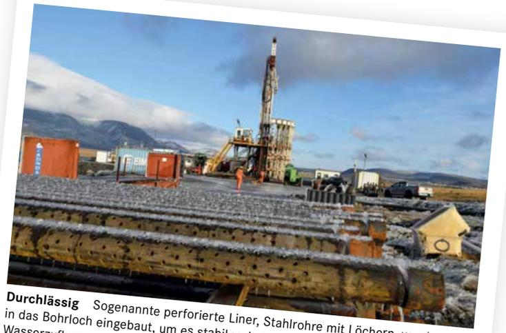
**Durchlässig** Sogenannte perforierte Liner, Stahlrohre mit Löchern, werden in das Bohrloch eingebaut, um es stabil zu halten und gleichzeitig einen Wasserzufluss zu ermöglichen. Bild: Hannes Hofmann
