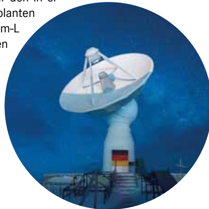
Seit 25 Jahren ist die DLR-Empfangsanlage GARS O'Higgins in der Antarktis in Betrieb. Selbst bei extrem stürmischen Bedingungen kann die 9-Meter-Antenne Satellitendaten empfangen. Bild: DLR (CC-BY 3.0)
