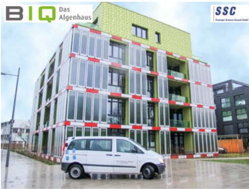
In der Gebäudefassade wachsen Algen unter CO<sub>2</sub>-Zufuhr aus der Heizungsanlage. Bild: HZG
