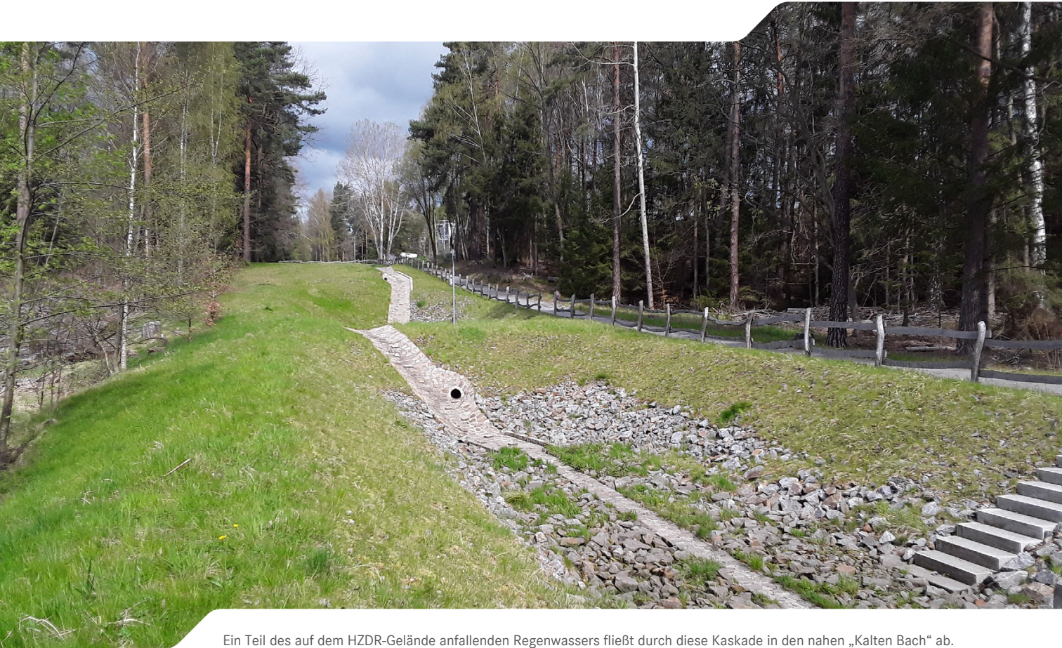
Ein Teil des auf dem HZDR-Gelände anfallenden Regenwassers fließt durch diese Kaskade in den nahen „Kalten Bach“ ab. Das Bauwerk sorgt für eine kontrollierte Einleitung des Wassers, damit es den Bach nicht überlastet.
