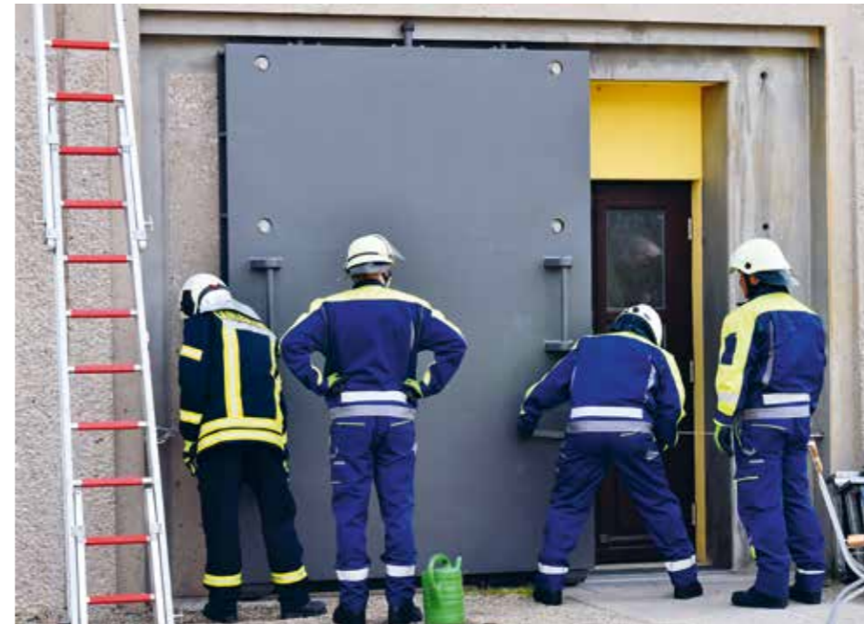
Bei diesem Einsatztraining schließen die Grimmaer Rettungskräfte auch eines der neuen Fluttore, welche die Stadt künftig vor schweren Überschwemmungen schützen sollen.
