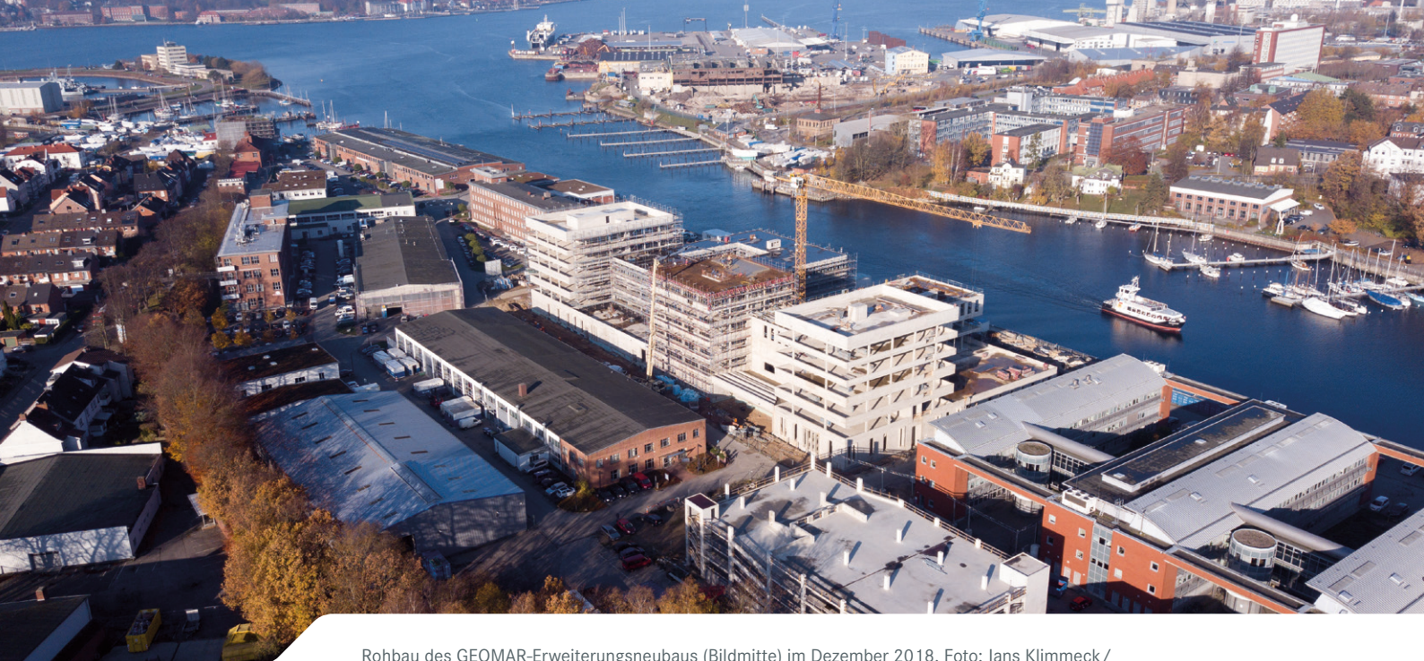
Rohbau des GEOMAR-Erweiterungsneubaus (Bildmitte) im Dezember 2018. Foto: Jans Klimmeck / GEOMAR
