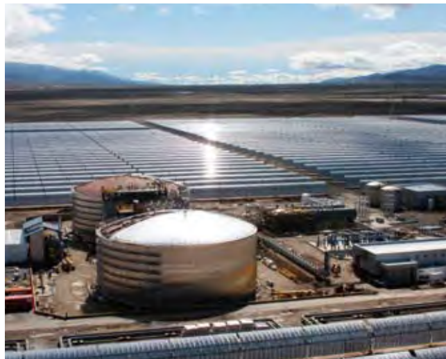
ANDASOL 1: 500.000 QUADRATMETER SPIEGELFLÄCHE FANGEN DAS SONNENLICHT EIN. Foto: Solar Millenium AG
