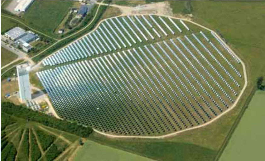
Mit dem Solarturm in Jülich können die DLR-Experten Innovationen bei der Stromerzeugung aus Sonnenhitze schneller und in einem anwendungsnahen Maßstab entwickeln und testen. Foto: DLR
