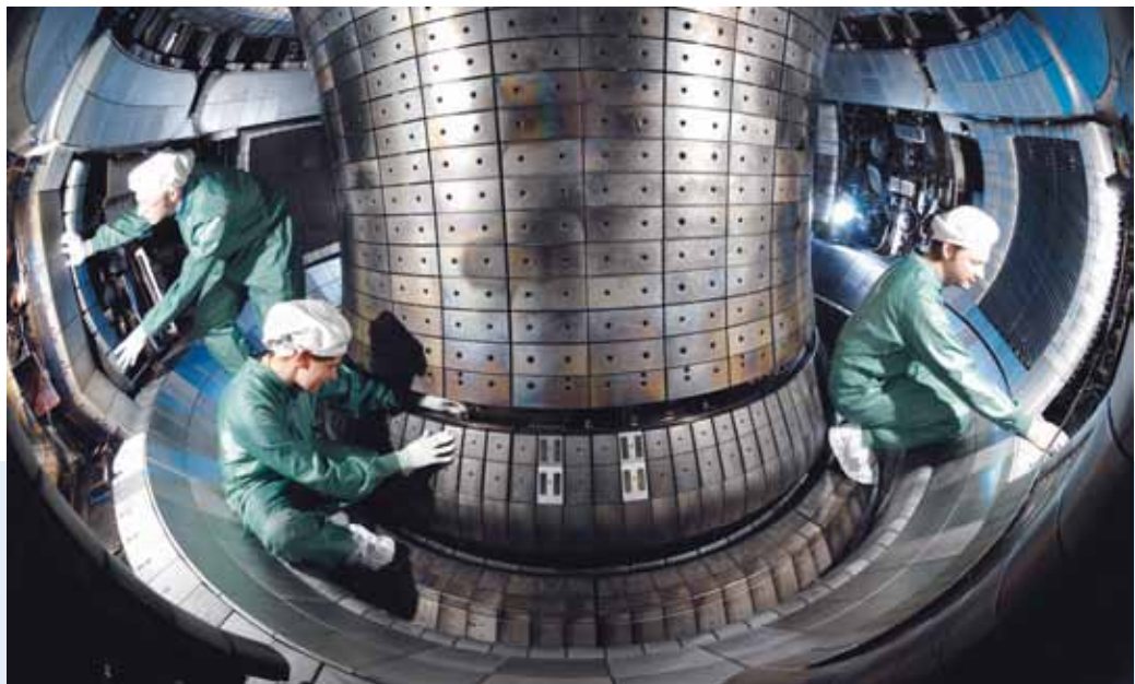
Einbau von Regelspulen in das Plasmagefäß der Fusionsanlage ASDEX Upgrade. Foto: IPP/V. Rohde
