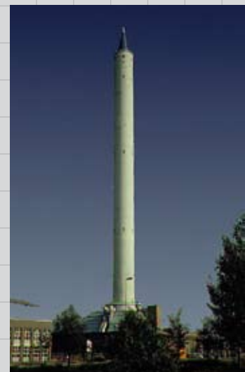
Im freien Fall wirkt die Massenträgheit der Schwerkraft entgegen. Im 146 Meter hohen Fallturm des Zentrums für angewandte Raumfahrttechnologie und Mikrogravitationsforschung (ZARM) an der Universität Bremen kann man 9 Sekunden lang „schwerelos“ arbeiten.
