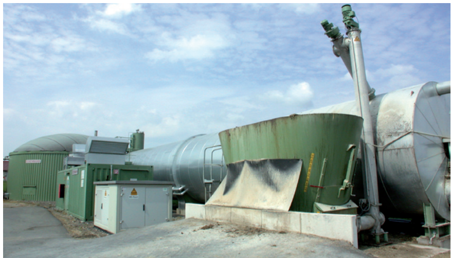
Biogasanlage auf einem Bauernhof in Niederbrechen, Hessen.
