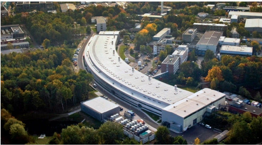
Die PETRA III-Experimentierhalle ist knapp 300 Meter lang und nimmt 30 neue Experimente auf.
