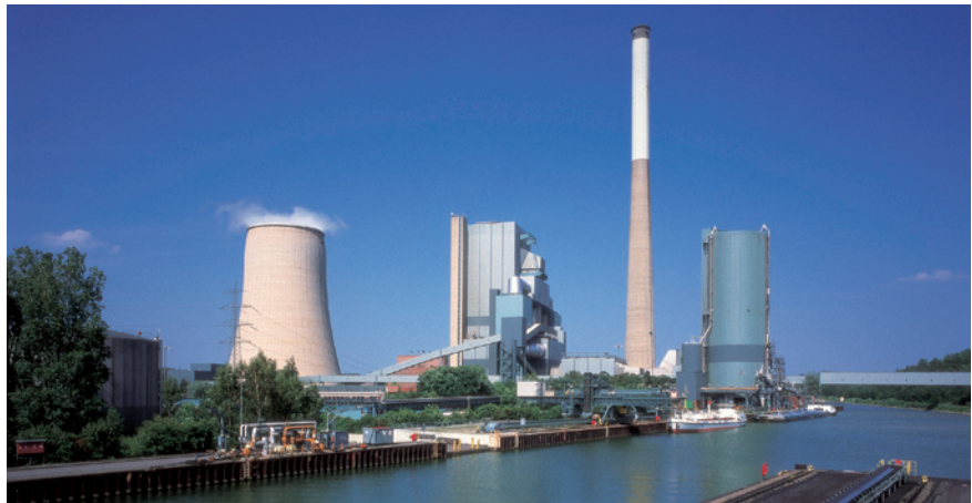
Steinkohlekraftwerk Bergkamen zur Erzeugung von Strom und Fernwärme.
