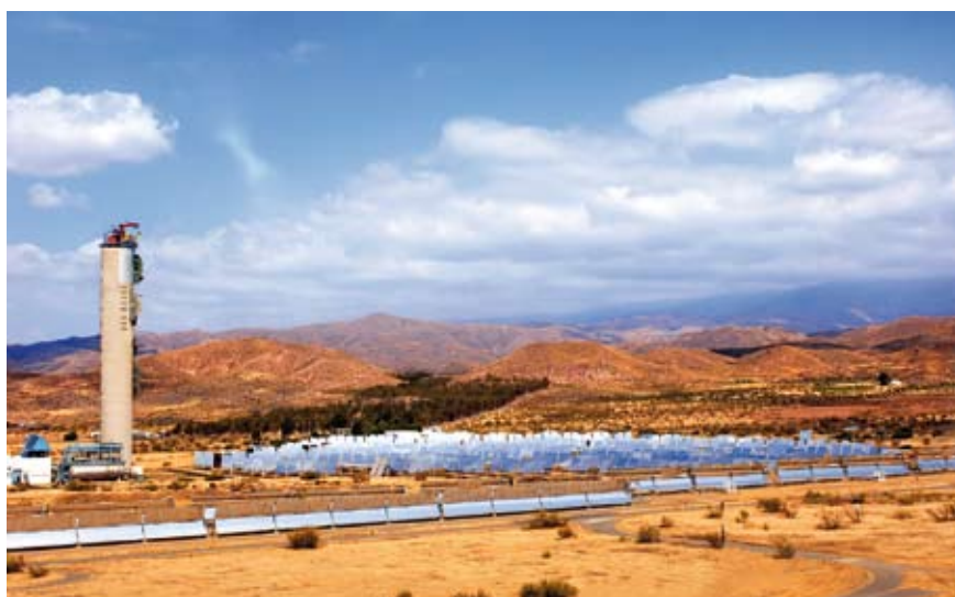
Die Helmholtz-Gemeinschaft leistet den größten Anteil der öffentlich geförderten Energieforschung in Deutschland. Dabei werden sehr unterschiedliche Themen abgedeckt. Das Foto zeigt das solare Turmkraftwerk auf der Plataforma Solar in Almería, Spanien, das von DLR-Experten mit entwickelt wurde. Foto: DLR
